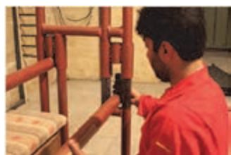
شکل ۱۷- نصب اجزاء دستگاه
