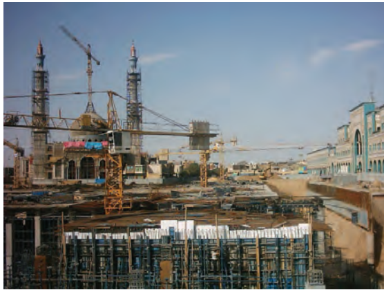
شکل ۱۱-۶- پروژه در حال ساخت میدان بزرگ امام خمینی (ره)
