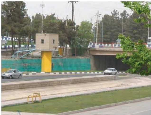
شکل ۱۸-۱- تصویر یکی از چاه‌های آب داخل رودخانه
