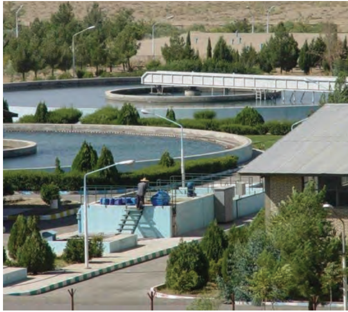
شکل ۳۲-۱- تصفیه‌خانه سد ۱۵ خرداد
