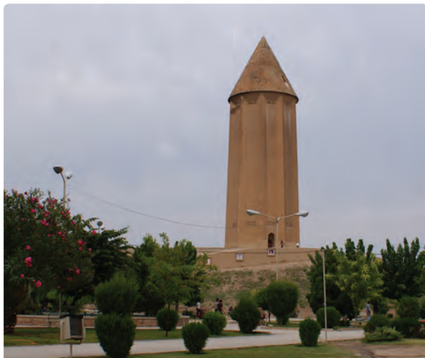
شکل ۴۰-۵- برج آجری قابوس بن وشمگیر - گنبد کاووس
