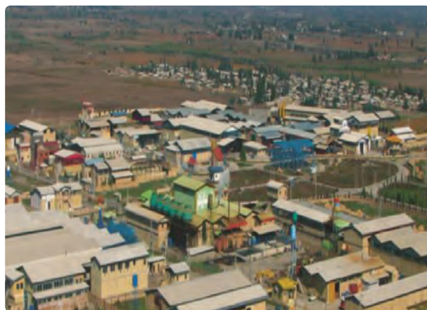
شکل ۲-۴- شهرک صنعتی علی آباد
