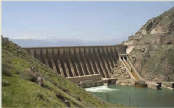
شکل ۱۳-۱- سد مخزنی سفیدرود در منجیل با ارتفاع ۹۲ متر و طول تاج ۴۲۵ متر، بزرگ‌ترین طرح آبیاری استان
