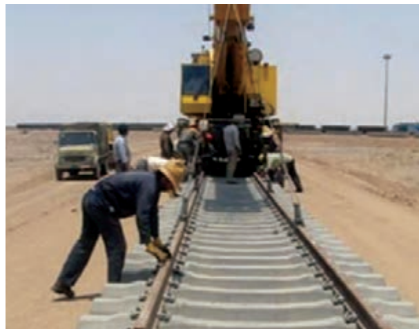
شکل ۱۵-۶- مراحل ساخت راه آهن قزوین - رشت - آستارا
