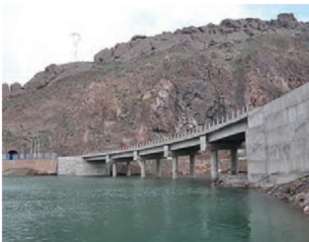
شکل ۱۶-۶- راه آهن قزوین - رشت - آستارا در حال احداث
