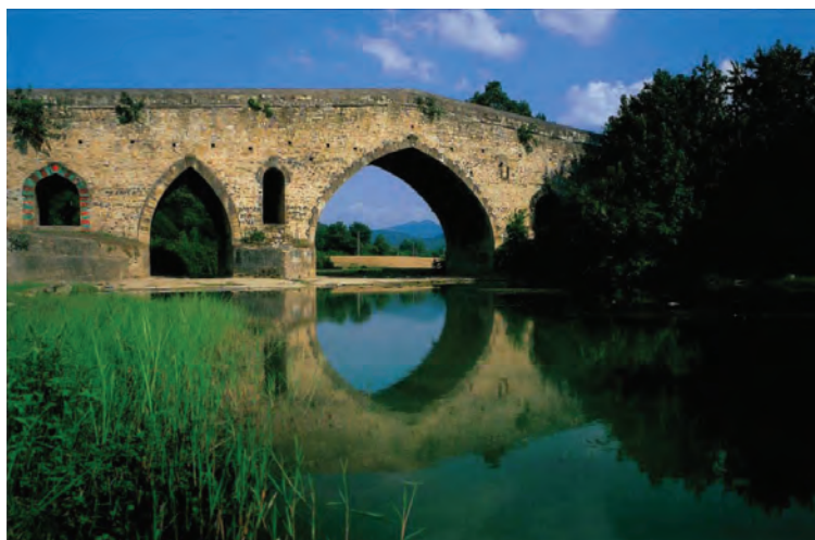
شکل ۲-۵- پل شاهپور در شیرگاه
