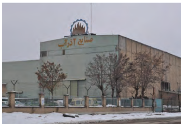
شکل ۱۸-۶- شرکت آذرآب اراک
