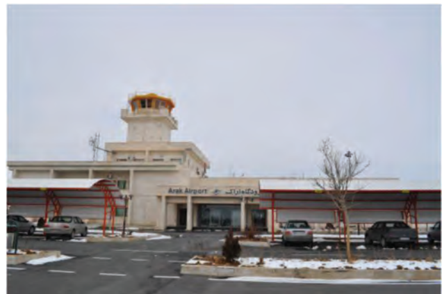
شکل ۱-۶- فرودگاه شهر اراک
