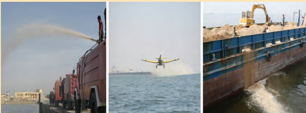
شکل ۶۸-۱- مجموعه عملیات پاشیدن دوغاب (خاک رس) جهت کنترل کشند قرمز
