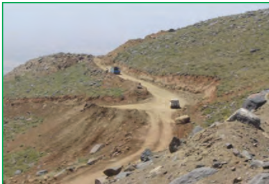
شکل ۵۹-۱- احداث راه در مراتع
