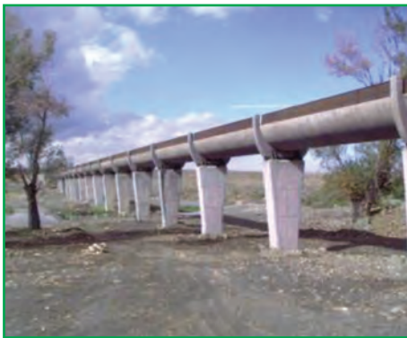
شکل ۱-۴۵- کانال انتقال آب (سیاه کمر)
