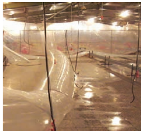
۳ کانال پلاستیکی هوای گرم در روی زمین
