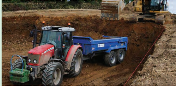
شکل ۱-۵۷- بارگیری نامناسب پی نورد
