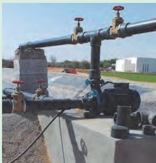
شکل ۱۲-۵. شیر فلکه لوله رانش
