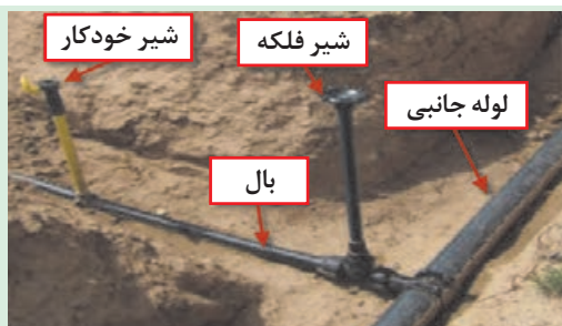
شکل ۱۳-۵. محل شیر فلکه روی بال
