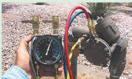
شکل ۳۱-۵. تنظیم فشار شیر فشار شکن
