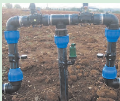
شکل ۳۲-۵. شیر و فشار سنج روی بال ها
