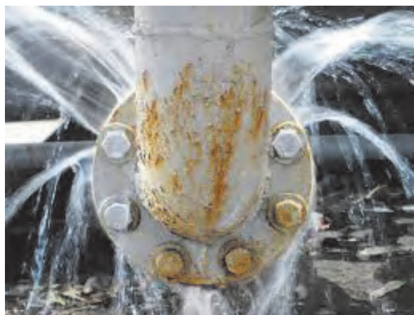
شکل ۲۴-۵. نشت آب بر اثر ضربه قوچ
