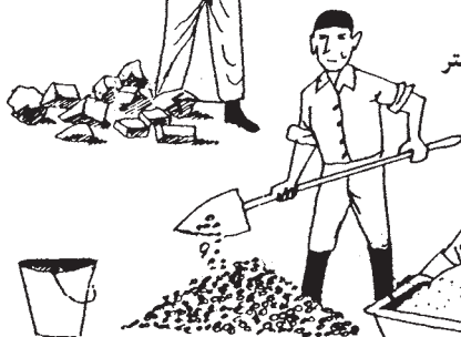
ماسه به ابعاد بین ۰/۰۶ میلی‌متر تا ۲ میلی‌متر
