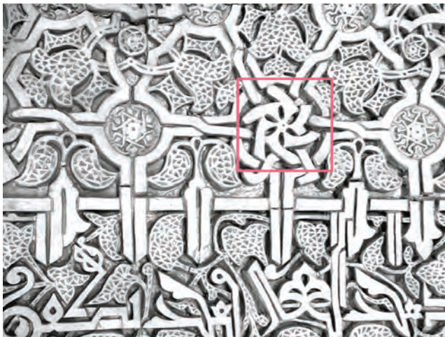
شکل ۳۳-۶. بخشی از گجبری مسجدی در ارومیه
