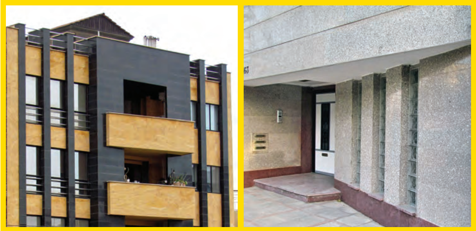
ب) نمای سنگی ساختمان
