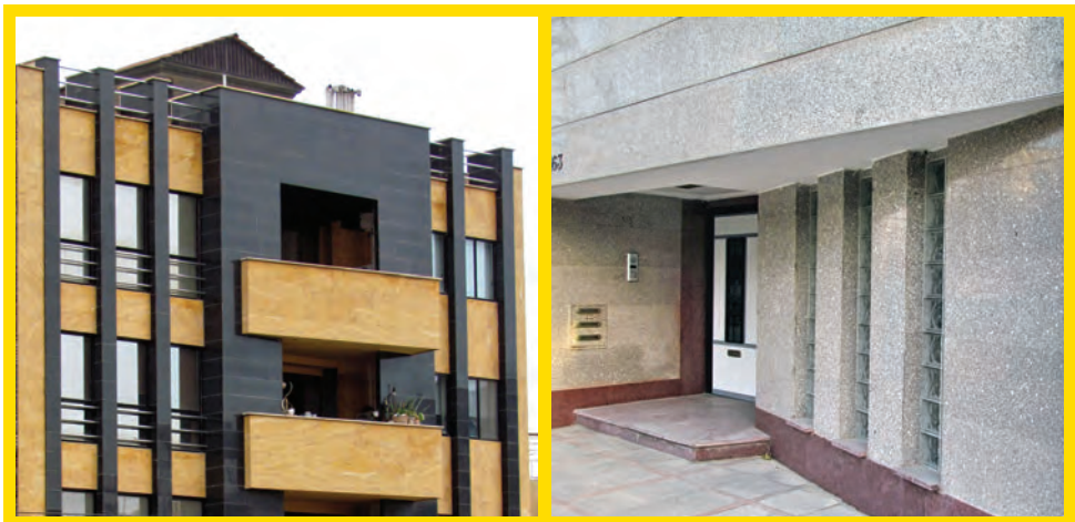
ب) نمای سنگی ساختمان
