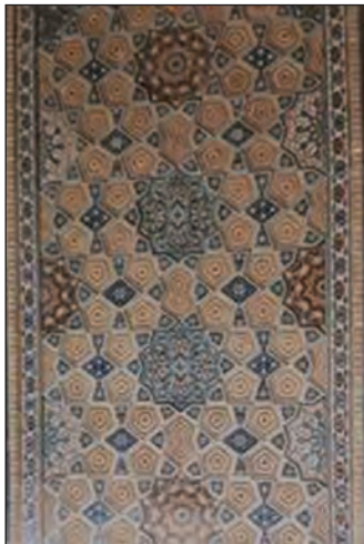
▲ کاشی‌کاری دیوار امامزاده محروق، اثر استاد زمرشیدی
