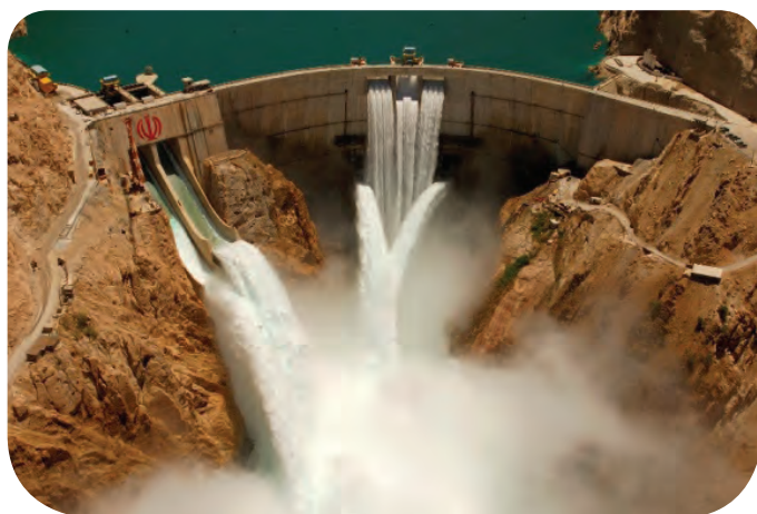
شکل ۳- سد و نیروگاه آبی کارون ۳ استان خوزستان
