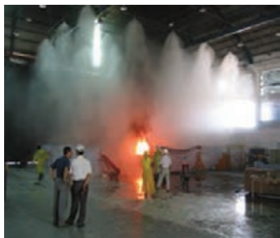
شکل ۱۱-۴- سیستم پاشش آب اطفاء حریق
