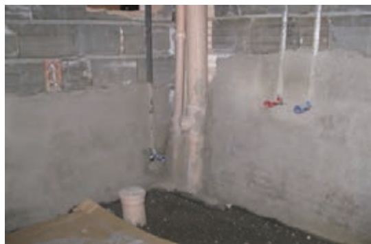
بستر عایق در روی دیوار هم مانند کف باید با ملات ماسه سیمان لایسه‌ای اجرا می‌شود.
