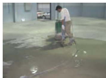
اجرای ملات برای مسطح کردن سطح
