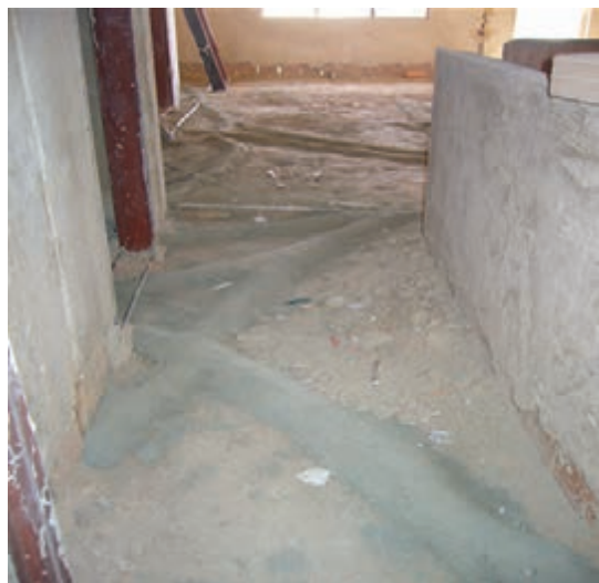
پوشش تأسیسات به منظور محافظت از آنها
