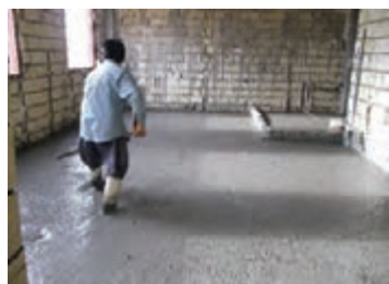
تسطیح فوم بتن قبل از خشک شدن
