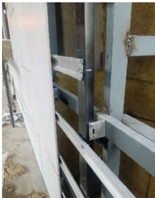
نمایی از اتصال قطعه به زیرسازی
