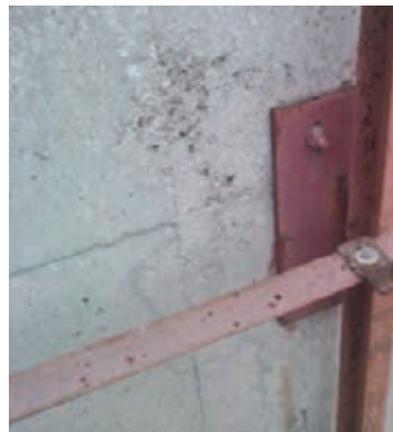
اتصال قطعات زیرسازی سنگ به دیوار
