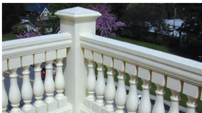
قطعات به شکل صراحی به عنوان دست انداز بالکن
