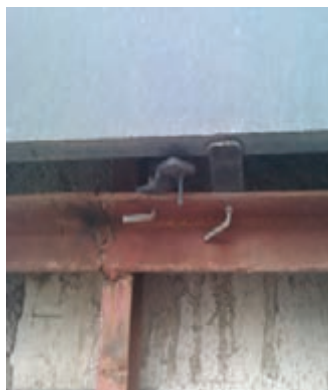
اتصال قطعات زیرسازی سنگ به دیوار
