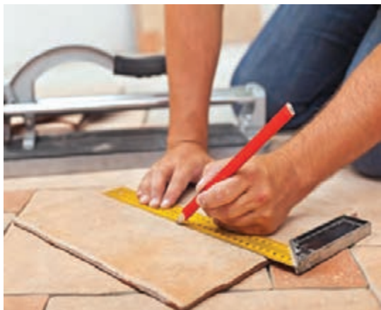
مشخص کردن مسیر برش سرامیک
