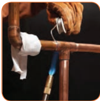
لجیم کاری نقره در لوله مسی
