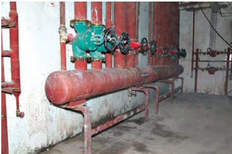
شکل ۱- نصب شیر تخلیه کلکتور
