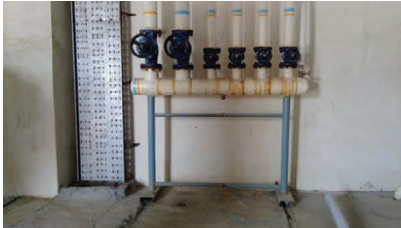
شکل ۲- نصب پایه کلکتور
