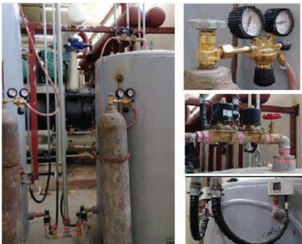
شکل ۲۳- مخزن انبساط بسته با متعلقات
