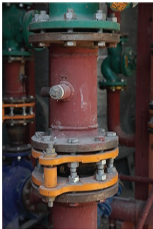
شکل ۲۰- ارتعاش گیر روی پمپ
