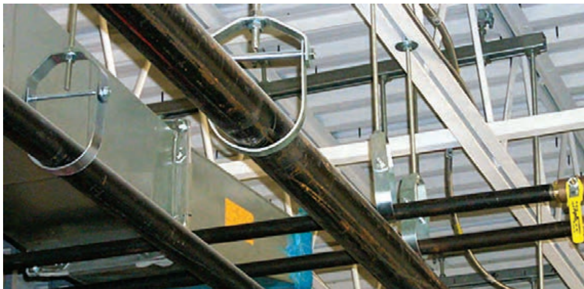
شکل ۱۲- نمونه‌ای از آویز سقفی
