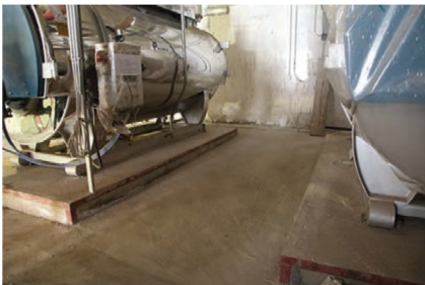
شکل ۱۴ - نصب دیگ روی فونداسیون
