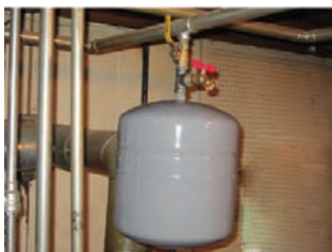
شکل ۲- مخزن انبساط بسته
