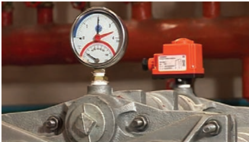
شکل ۲۱- نصب کنترل کننده و نشان دهنده دیگ
