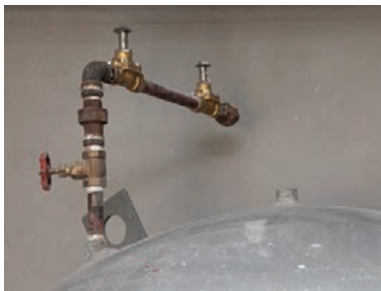
شکل ۲۳- اتصال لوله هواگیری مخزن
