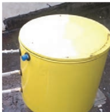
شکل ۳- مخزن انبساط باز با عایق
