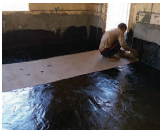
شکل ۴-۱۱- اجرای قیرگونی کف فضای داخلی
