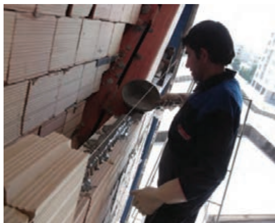
شکل ۴-۶- ملات ماسه سیمان جهت اتصال بلوک‌ها
