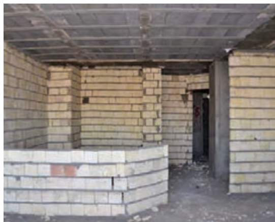
شکل ۴-۴- تیغه چینی داخلی با بلوک سفالی
