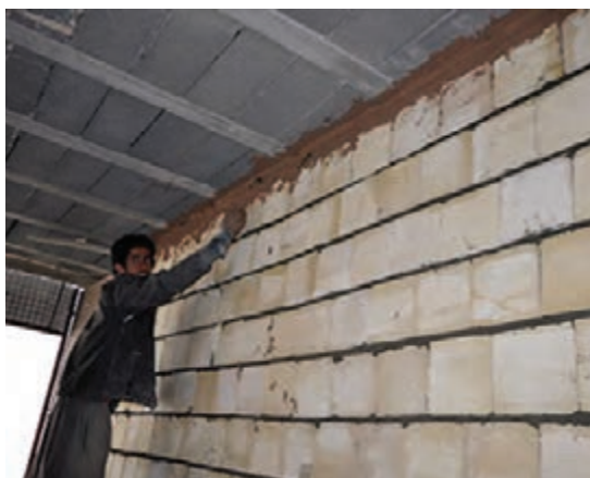
شکل ۲-۴- اجرای دیوار چینی با بلوک سفالی
