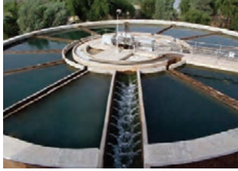
آب در تصفیه‌خانه
