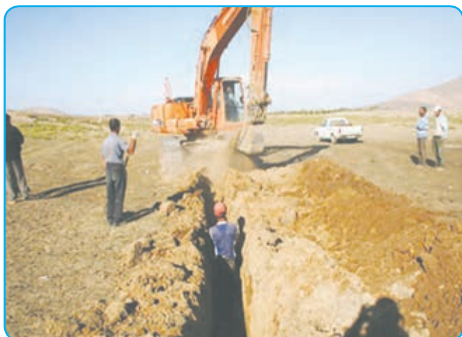
کندن زمین با بیل مکانیکی
