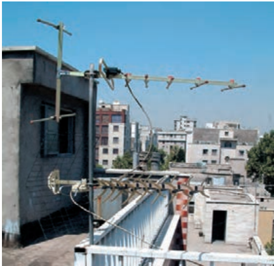
شکل ۱-۶۹- آنتن VHF و UHF روی دکل
