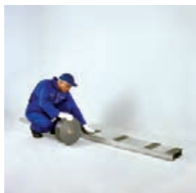
اجرای نوار عایق بر روی استاداها
