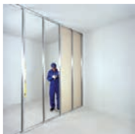
برای نصب پانل ها از پیچ مخصوص استفاده می شود نحوه صحیح در دست گرفتن پیچ گوشتی برقی
