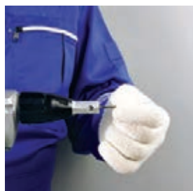
برای نصب پانل ها از پیچ مخصوص استفاده می شود نحوه صحیح در دست گرفتن پیچ گوشتی برقی
