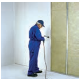
اجرای پانل‌ها در دو طرف دیوار
