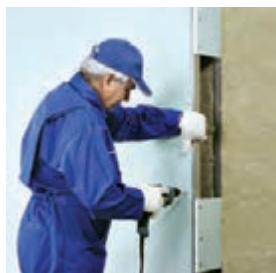
اجرای پانل‌ها در طرف دیگر دیوار
