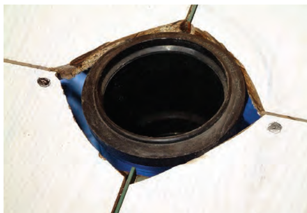
شکل ۲۴۴-۳- قرار دادن بوگیر در داخل زانویی
