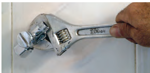
شکل ۳-۴۸ سفت کردن شیر پیسوار با آچار فرانسه
