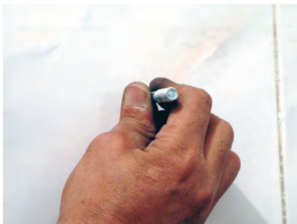
شکل ۳-۴۳- بستن پیچ‌ها در درون رولپلاک‌ها با دست
