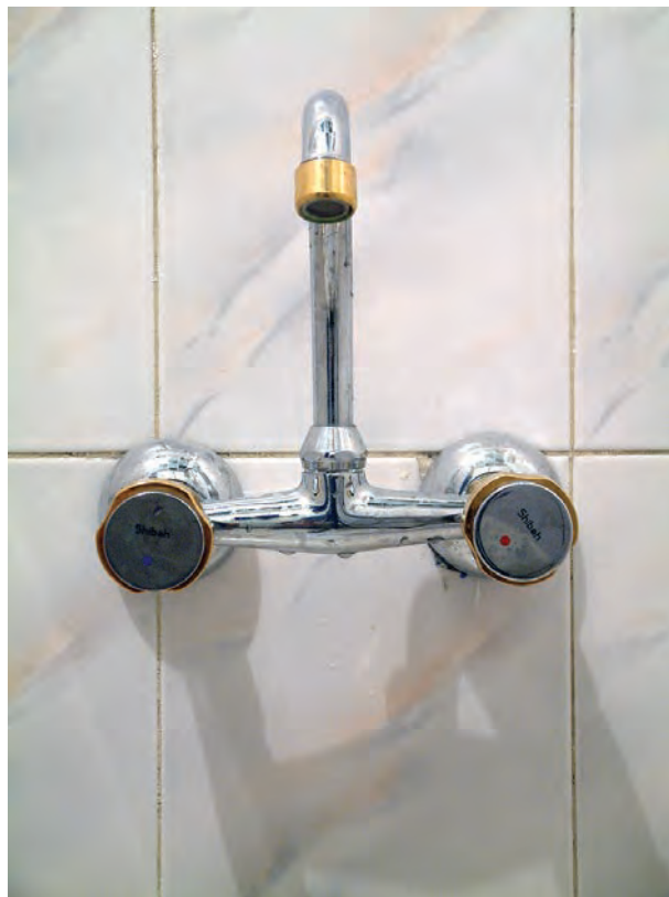
نصب شیر مخلوط دیواری
