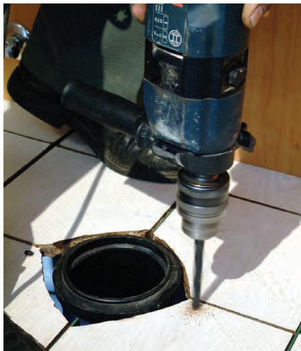
شکل ۲۴۶-۳- سوراخ کاری محل‌های علامت گذاری شده
