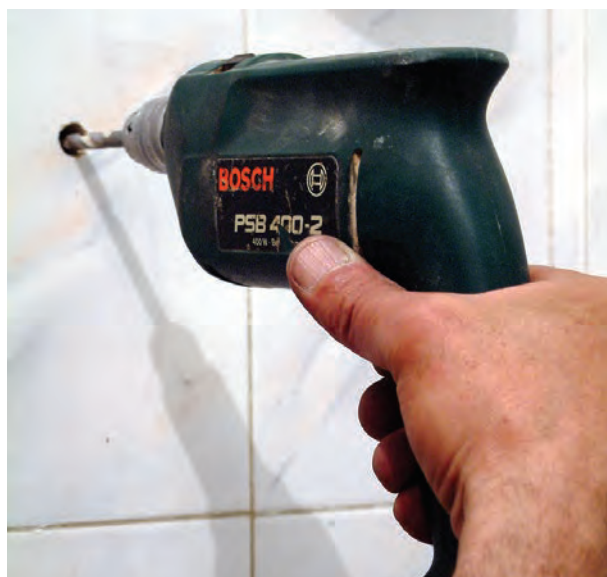
شکل ۳-۴۱- سوراخ‌کاری محل نصب پیچ‌ها
