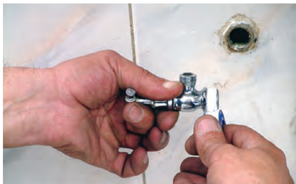
شکل ۱۴۲-۲ پیچیدن نوار تفلون به دنده‌ی \frac{۲}{۳} شیر پیسوار
