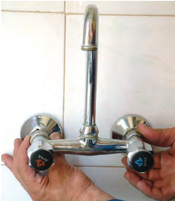
شکل ۱۷۲-۲- پیچیدن مهره‌ها به دنباله‌های شیر مخلوط
