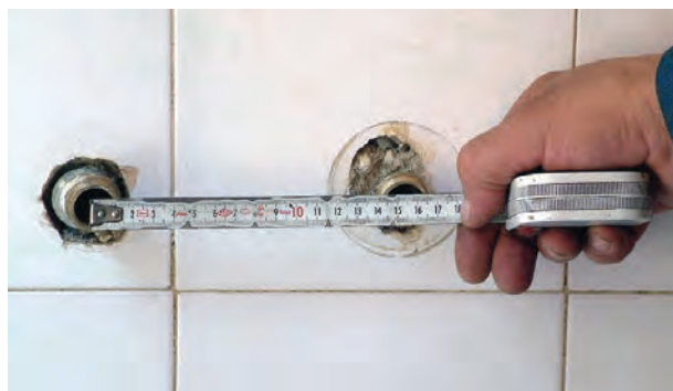
شکل ۲-۲۰۲- کنترل نمودن فاصله‌ی دنباله‌ها به وسیله‌ی متر
