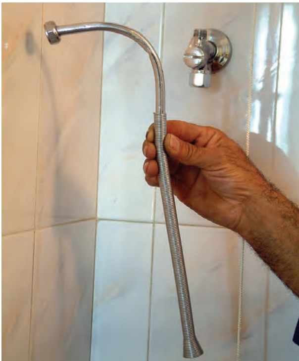
شکل ۲۲۱-۳- خم زدن لوله‌ی پیسوار به وسیله‌ی فنر لوله خم کن
