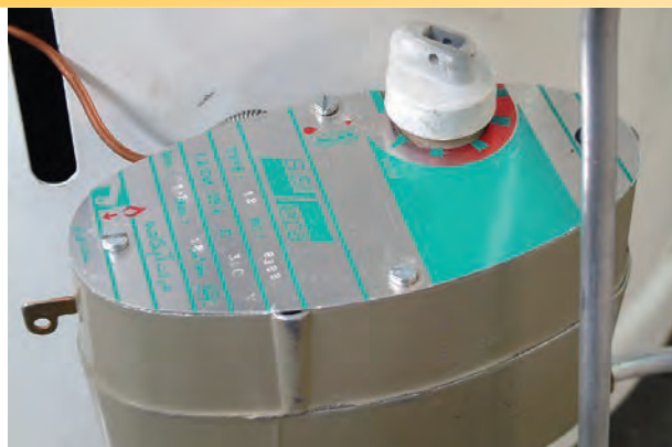
شکل ۱-۵۲- قرار دادن کلید گردان در حالت خاموش
