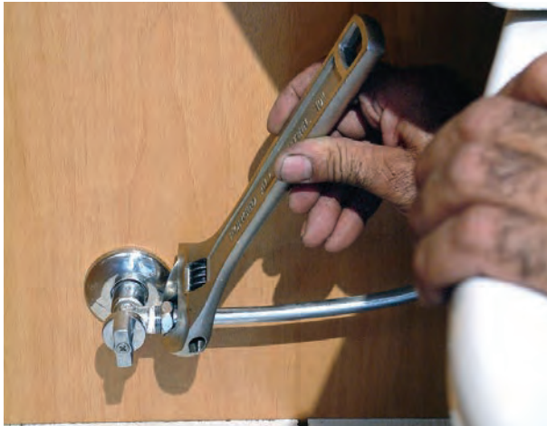
شکل ۲۵۶-۳- سفت کردن مهره‌ی شیر پیسوار
