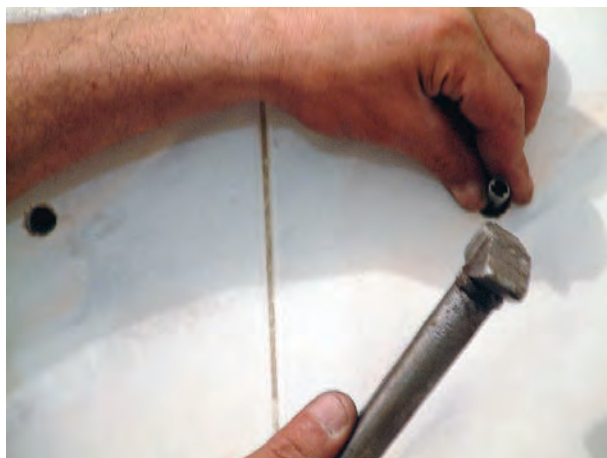
شکل ۳-۴۲- کوبیدن رولپلاک‌ها در درون سوراخ‌ها
