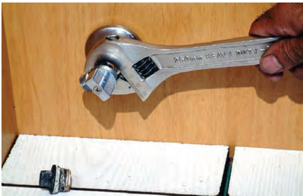
شکل ۳-۲۵۴- سفت کردن شیر پیسوار
