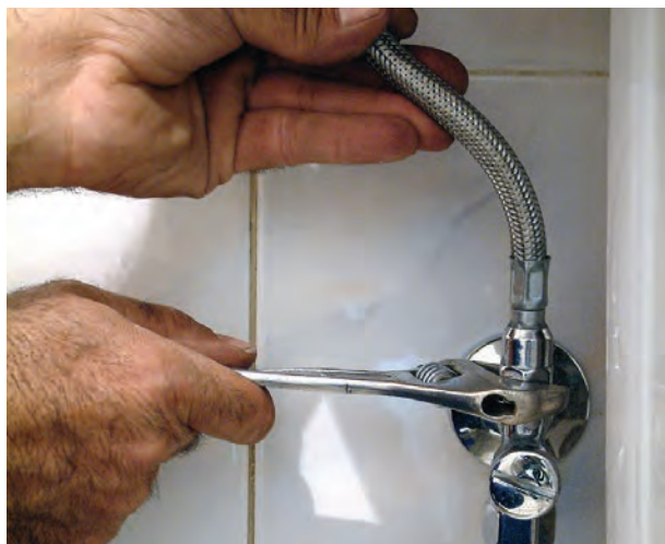
شکل ۳-۴۹ سفت کردن مهره‌های شیلنگ به شیر پیسوار
