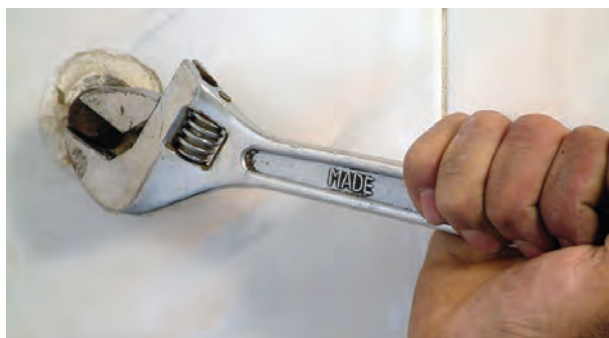
شکل ۱۹۸-۲- باز کردن درپوش‌ها
