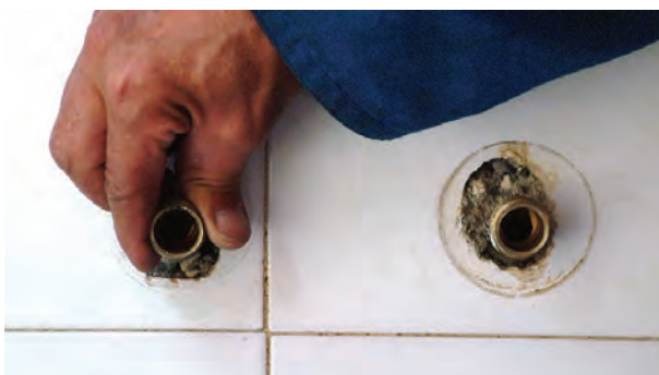
شکل ۲-۱۸۴- بیچیدن دنباله‌ها به محل نصب شیر
