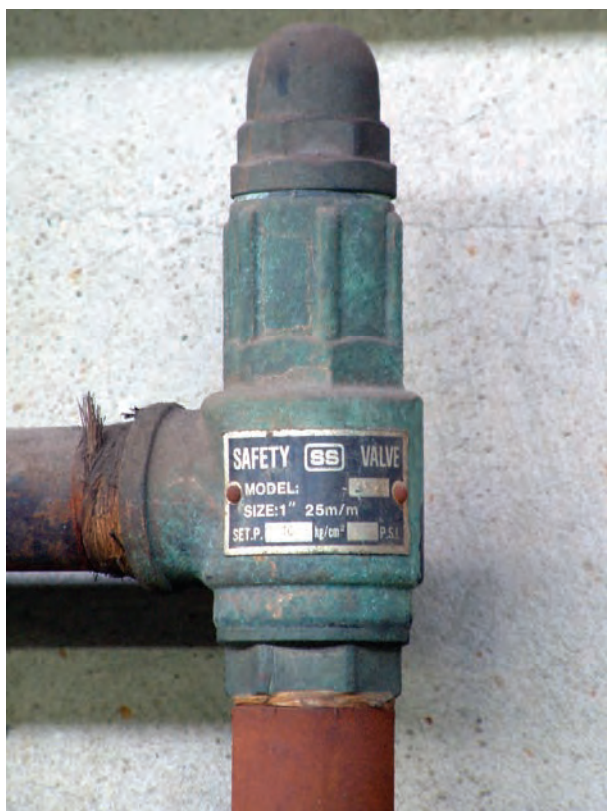
شکل ۱۰۶-۲ شیر اطمینان حساس در برابر فشار
