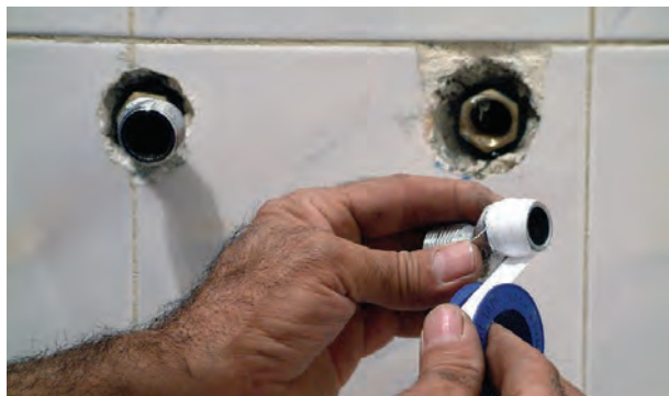
شکل ۱۹۹-۲- پیچیدن نوار تفلون به دور دنده‌ی \frac{1}{4} دنباله‌ی شیر مخلوط
