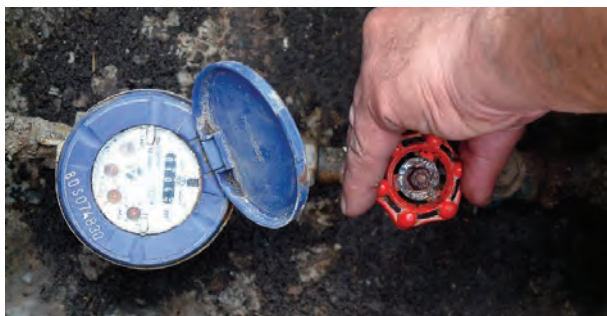
شکل ۱۹۵-۲- باز کردن شیرفلکه‌ی اصلی
