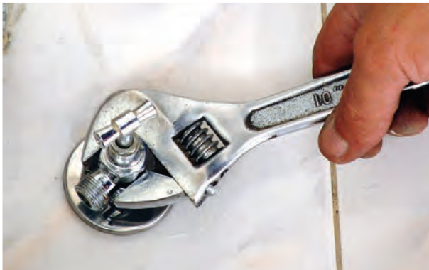
شکل ۲۲۰-۳- سفت کردن شیر پیسوار با آچار فرانسه
