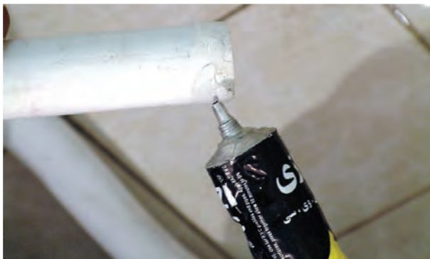
شکل ۲۰۵-۳ زدن چسب به لوله‌های تخلیه
