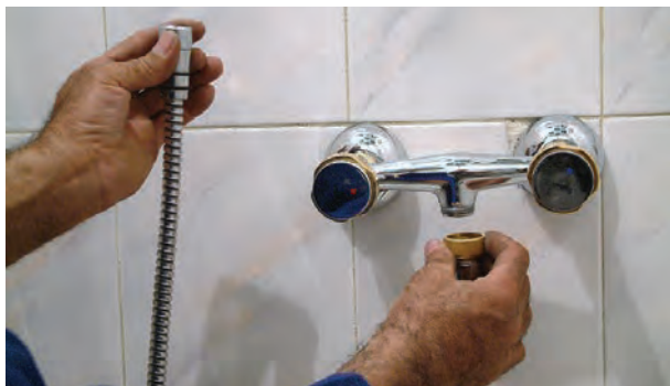
شکل ۱۹۱-۲- اتصال شیلنگ آفتابه به شیر مخلوط توالت
