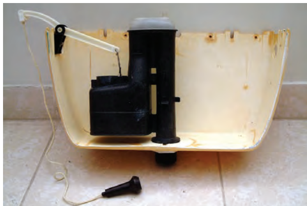
شکل ۲۰۷-۳- نصب پمپ تخلیه درون مخزن فشار
