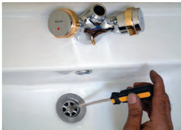
شکل ۳-۴۰- نصب زیراب بر روی دستشویی
