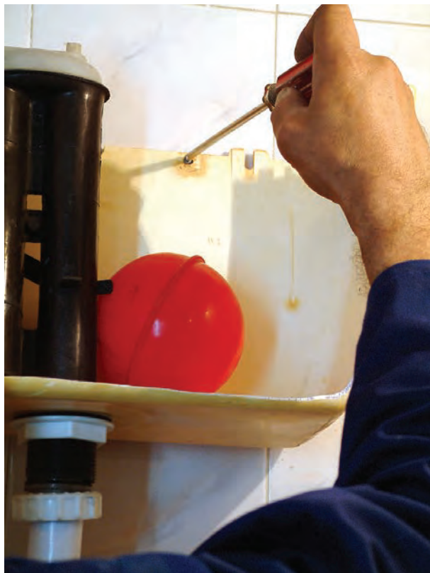
شکل ۲۱۳-۳- نصب مخزن فشاری به دیوار
