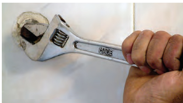
شکل ۱۴۱-۲ باز کردن درپوش
