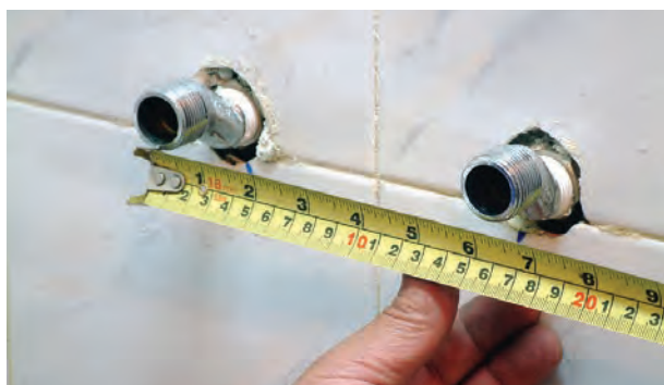
شکل ۱۶۸-۲ کنترل اندازه‌ی محور تا محور دنباله‌ها
