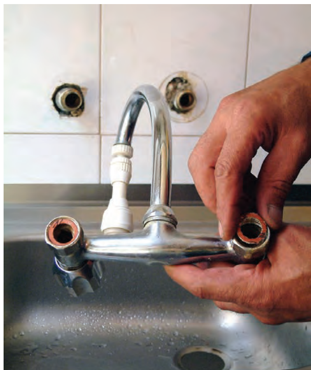
شکل ۲-۱۷۱- قراردادن واشر درون مهره‌ی تنه شیرمخلوط
