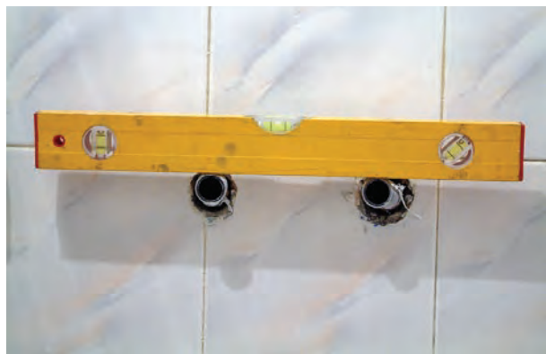
شکل ۲-۱۶۹- کنترل صاف بودن دنباله‌ها
