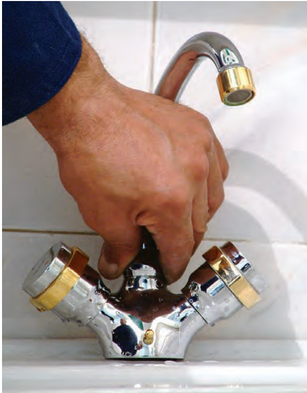
شکل ۳-۵۰- جا زدن عَلم شیر و بستن مهره‌ی آن
