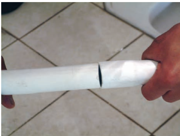
شکل ۲۰۶-۳ جا زدن لوله‌های تخلیه در درون یکدیگر
