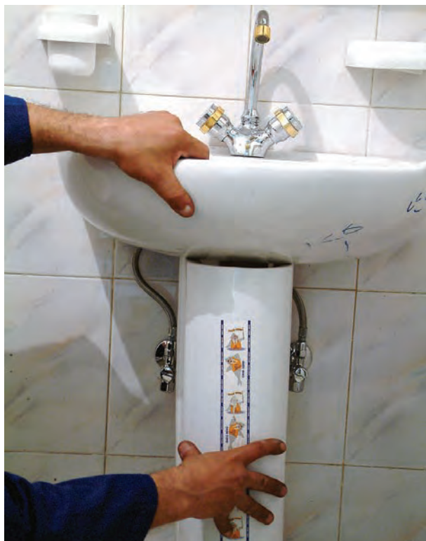
شکل ۳-۵۸- قرار دادن پایه‌ی دست‌شویی در زیر آن
