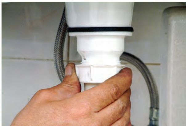
شکل ۳-۵۶- بستن مهره‌ی لوله‌ی عمودی سیفون به زیراب
