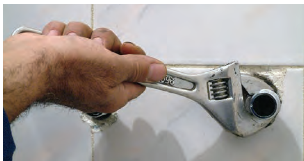
شکل ۱۶۷-۲ سفت کردن دنباله‌ها با آچار فرانسه
