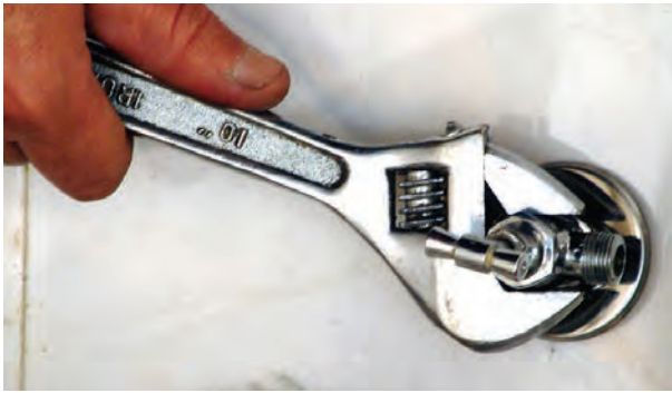
شکل ۱۴۴-۲- سفت کردن شیر پیسوار با آچار فرانسه
