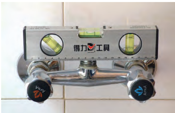
شکل ۱۷۴-۲- سنجش تراز بودن شیرمخلوط دیواری
