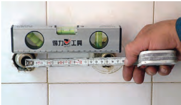
شکل ۲-۱۸۶- کنترل صاف بودن و اندازه‌ی دنباله‌ها
