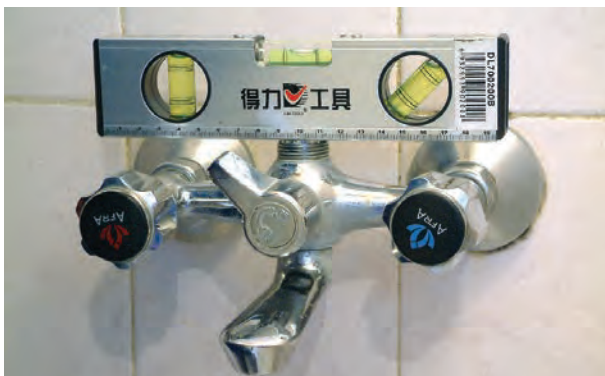
شکل ۲-۲۰۷- سنجش تراز بودن شیر مخلوط دوش
