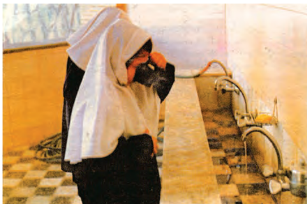
شکل ۲-۵۹- چکه کردن شیر آب
