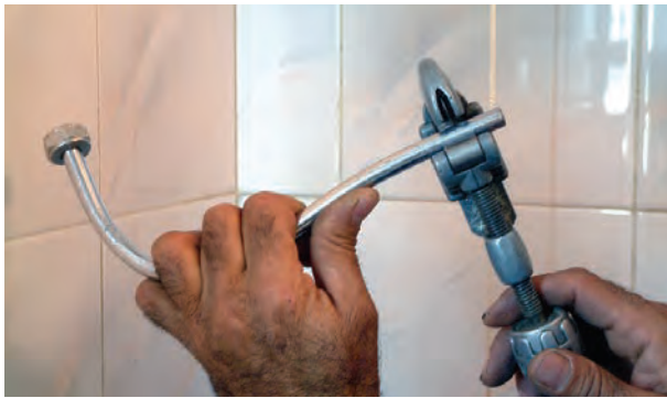
شکل ۲۲۲-۳- بریدن لوله‌ی پیسوار به وسیله‌ی لوله‌بر
