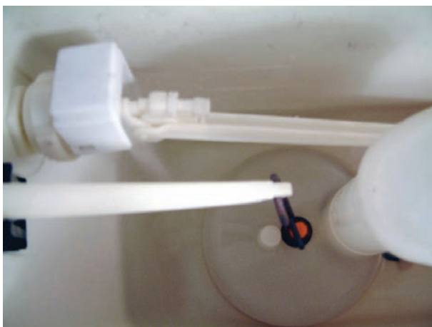
شکل ۲۲۴-۳- بر شدن مخزن فشاری
