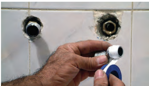
شکل ۲-۱۸۳- بیچیدن نوار تفلون به دنباله‌ها
