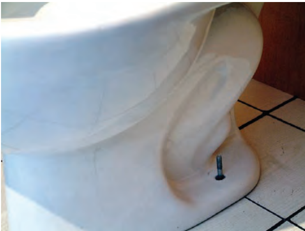
شکل ۲۴۸-۳- قرار دادن توالت فرنگی در محل خود
