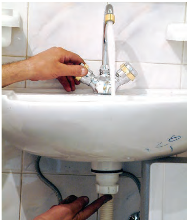
شکل ۳-۵۷- عمل کنترل نشت آب از محل‌های اتصال
