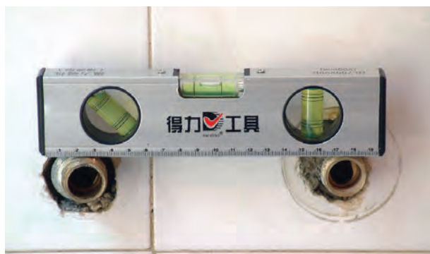
شکل ۲-۲۰۳- کنترل تراز بودن دنباله‌ها
