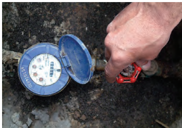
شکل ۲-۶۰- بستن شیر فلکه‌ی اصلی آب ساختمان
