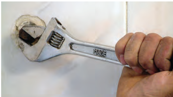
شکل ۲-۱۸۲- بازکردن درپوش‌ها
