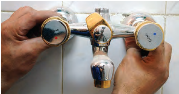
شکل ۲-۲۰۵- بستن مهره‌های شیر مخلوط دوش با دست
