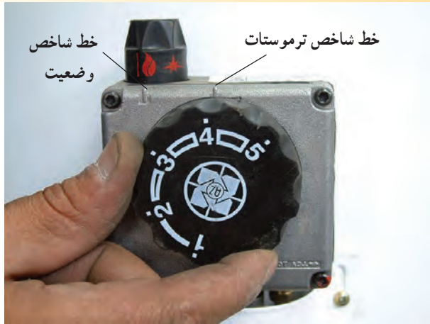
شکل ۱-۱۱۰- تغییر کلید تنظیم دما (ترموستات)
