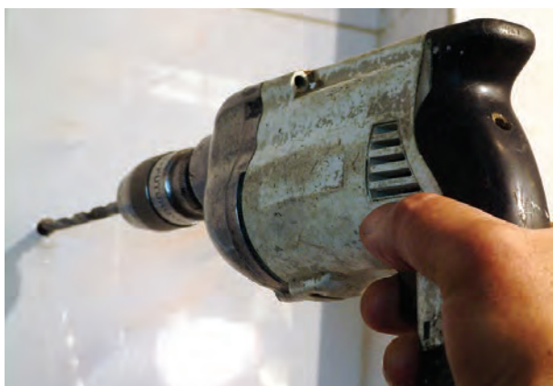
شکل ۱۹۲-۲- سوراخ کردن محل نصب بست آویز
