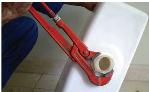
شکل ۲۰۸-۳- سفت کردن مهره‌ی پمپ تخلیه
