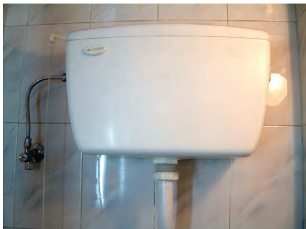
نصب مخزن فشاری
