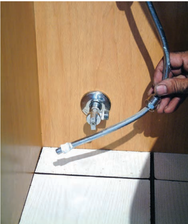
شکل ۳-۲۵۵- خمکاری لوله‌ی پیسوار
