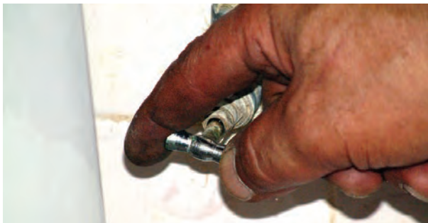
شکل ۱۴۶-۲- عمل هواگیری
