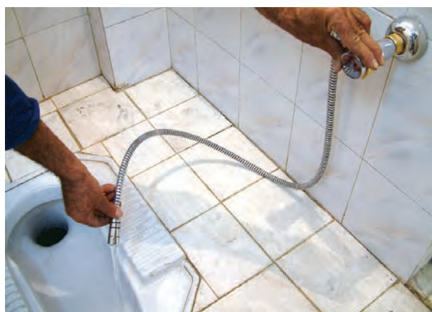
شکل ۱۹۶-۲- عمل هواگیری شیرمخلوط توالت
