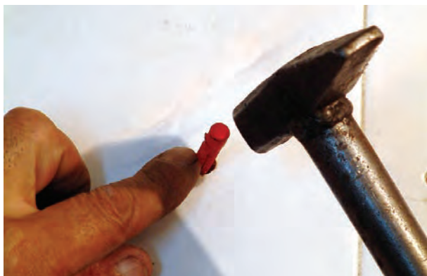
شکل ۱۹۳-۲- کوبیدن رولپلاک درون سوراخ
