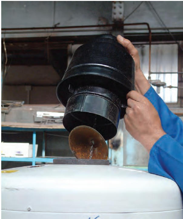
شکل ۱۱۵-۱- برداشتن کلاهک تعدیل از روی دودکش
