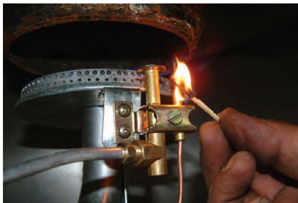
شکل ۱-۱۰۵ مشتعل کردن شمعی به وسیله‌ی شعله‌ی کبریت
