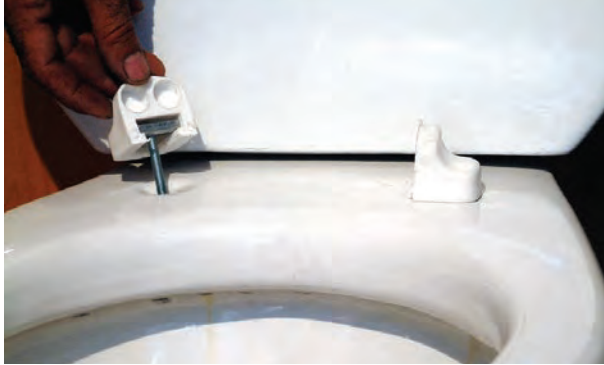
شکل ۳-۲۵۳- اتصال بست‌های نگهدارنده به توالت فرنگی
