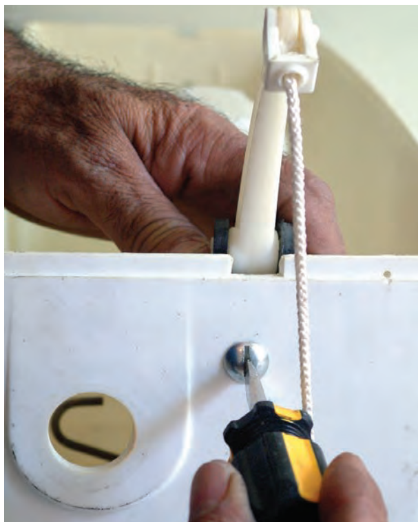
شکل ۲۰۹-۳- اتصال اهرم به بدنه‌ی مخزن فشاری
