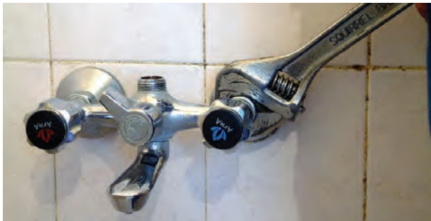
شکل ۲-۲۰۶- سفت کردن مهره‌های شیر با آچار
