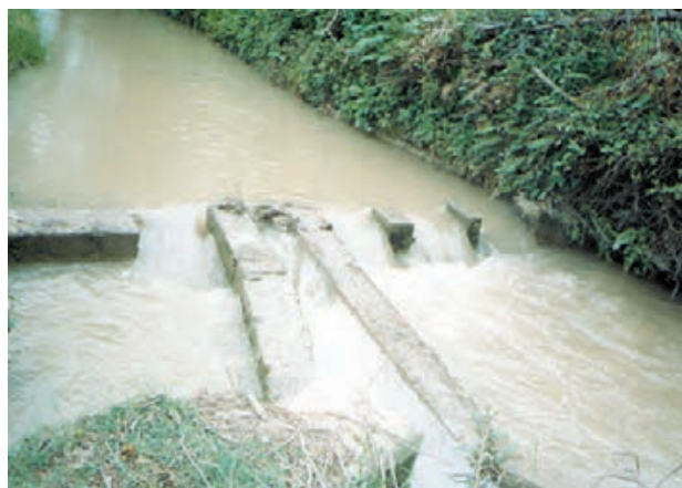
شکل ۲-۸- مقسم ثابت
