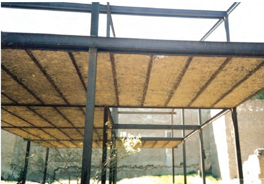
تصویر ۱۰ - تیرریزی سقف طاق ضربی
