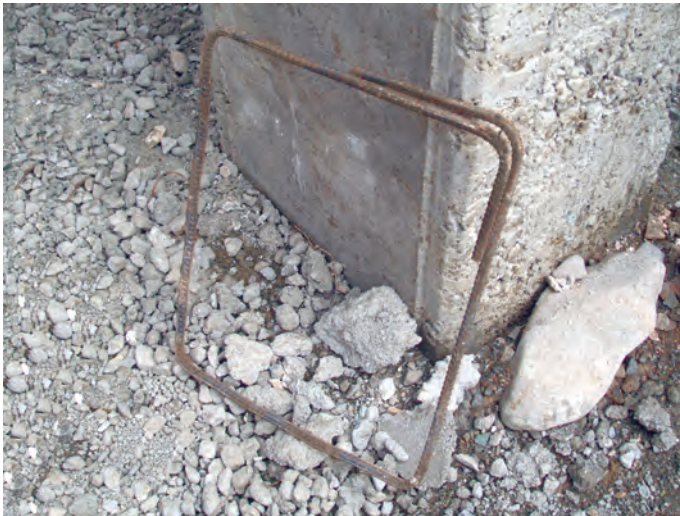
تصویر ۷ - نمونه‌ی یک خاموت
