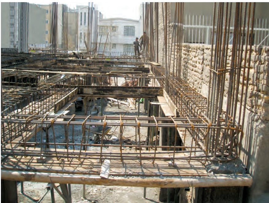
تصویر ۱۲ - نحوه‌ی قرارگیری آرماتورهای کلاف‌های بتنی
