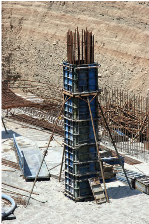
تصویر ۴ - قالب‌بندی فلزی ستون
