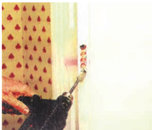
شکل ۱۰-۴۵ - تفلیهی محل قفل با دریل.
