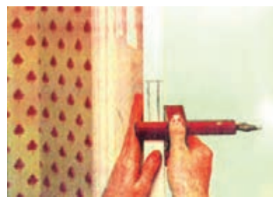
شکل ۱۰-۴۳ - فلشکشی محل قفل با فلشکشی تیره‌دار.
