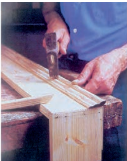
شکل ۱۳-۱۰. نصب زهوار با میخ.
