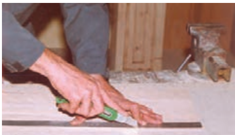
شکل ۵-۲۹- برش (روکش با کاتر)
