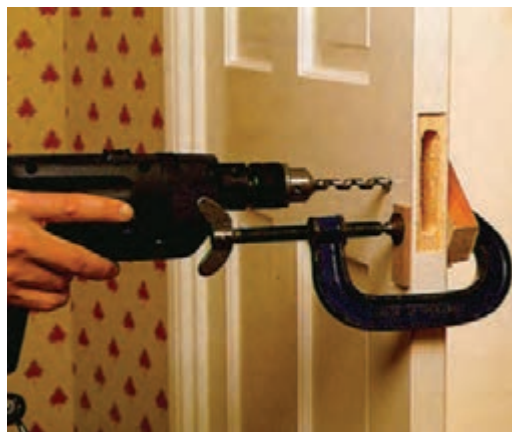
شکل ۱۰-۴۸- سوراخ‌کاری ممل پلاک و دستگیره‌ی قفل.
