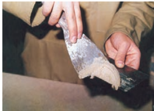
شکل ۸-۴- کاربرد لیسه و کاردک هنگام بتونه کاری.
