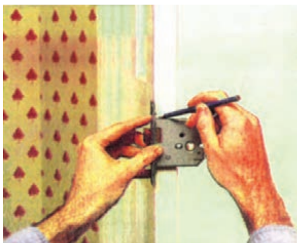
شکل ۱۰-۴۴ - فلشکشی محل قفل (روی درِ کار).
