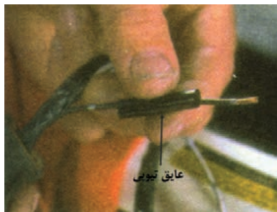
شکل ۶-۶۳- وارد کردن سیم به داخل عایق تیوبی
