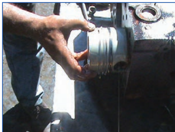
شکل ۱۹۷-۴- قرار دادن پیستون در سیلندر
