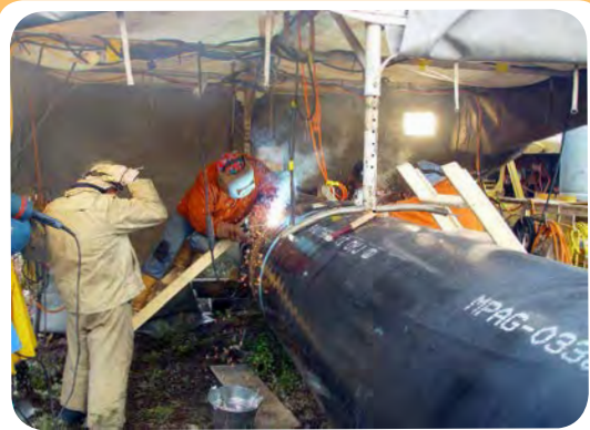
ن) کارگاه ساخت خط لوله
