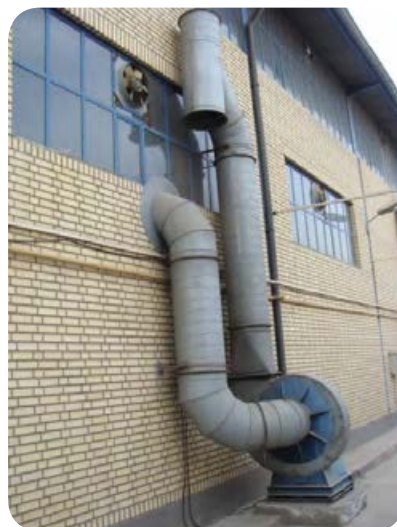
نمونه‌ای از سیستم تهویه موضعی در اتاقک‌های مخصوص جوشکاری
