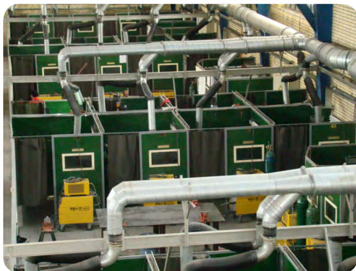
نمونه‌ای از سیستم تهویه موضعی در اتاقک‌های مخصوص جوشکاری
