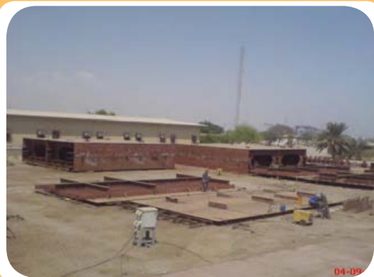
د) کارگاه ساخت اسکلت فلزی ساختمان
