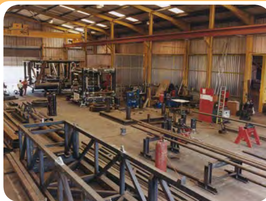
الف) کارگاه ساخت سازه‌های ساختمانی
