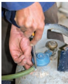
شکل ۱-۶۶ ب سفت کردن بست
