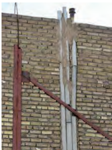
شکل ۴-۶ الف دودکش نادرست
