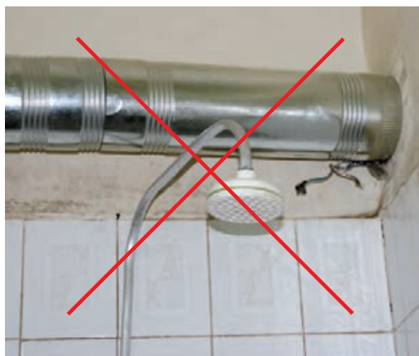
شکل ۳-۱۱ عبور غیر مجاز دودکش
