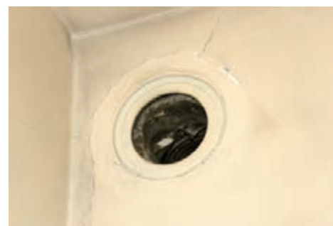
شکل ۱-۴ دودکش در محل نصب آب گرم کن.
