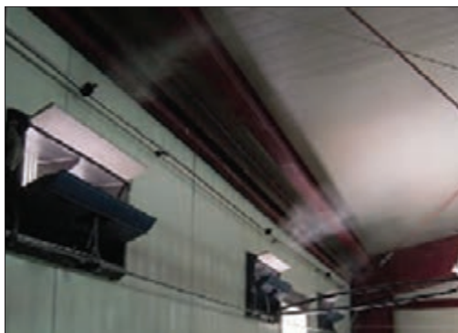
شکل ۲- نحوه خنک شدن هوا توسط سیستم نازل مه پاش
