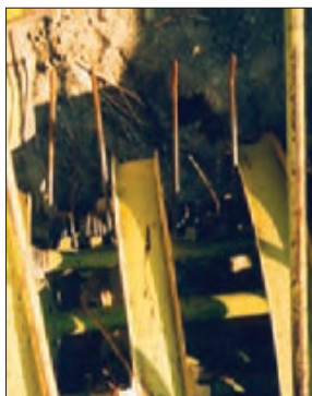
شکل ۹- پایه انگشتی شکسته
