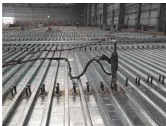
شکل ۳۴ ▲ روش نصب گل‌میخ روی سقف عرشه فولادی
