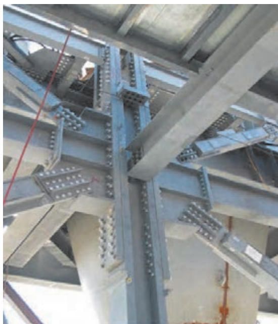
شکل ۵۱ ▲ اتصال مهاربندی
