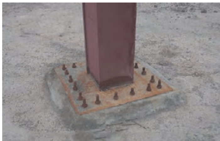
شکل ۴۹ ▲ اتصال مستقیم ستون به کف ستون
