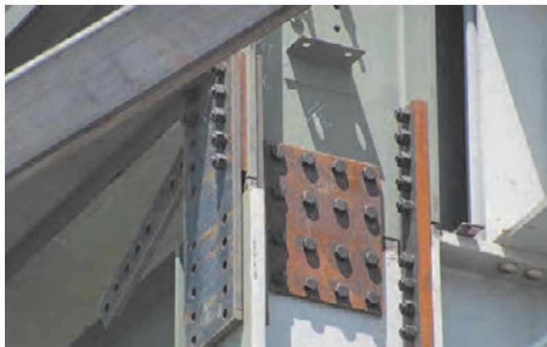
شکل ۵۷ وصله پیچی ستون
