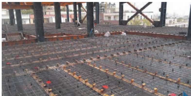
شکل ۳۲ ▲ سقف مرکب به همراه برشگیرها
