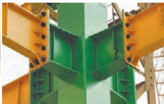
شکل ۵۰ ▲ انواع اتصال فلنجی
