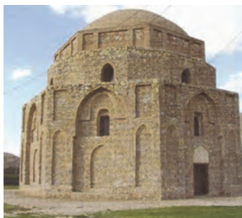
شکل ۱۰۶-۲- کرمان، گنبد جبلیه، سنگ لاشه و ملات
