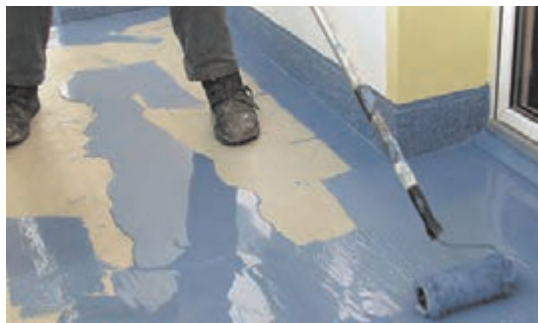
شکل ۴-۱۰ یکی از روش‌های اجرای اپوکسی
