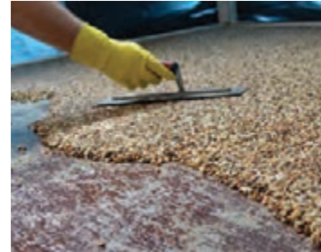
شکل ۳-۴۳- نمایش نحوه پخش و اجرای اپوکسی گرانیته
