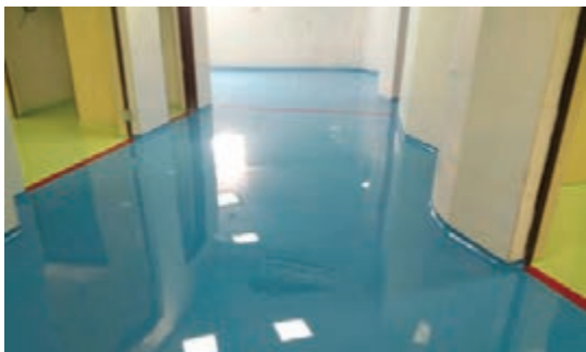
شکل ۴-۱۱ اپوکسی به عنوان لایه نهایی کفپوش
