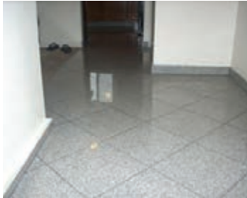
شکل ۳-۴۵- کف‌سازی نهایی با پوشش اپوکسی گرانیته شطرنجی
