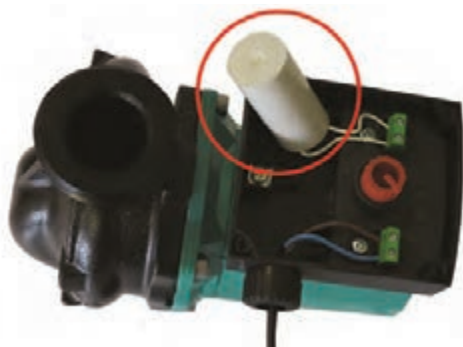
شکل ۳۵- خازن در جعبه برق موتور
