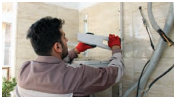
شکل ۷- نصب یونیت خارجی
