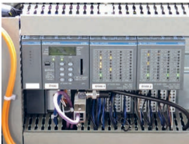
شکل ۹- PLC به همراه دو عدد ماژول ورودی و خروجی
