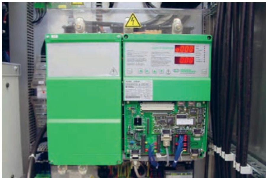
شکل ۴۵- یک دراپور برای راه‌اندازی و کنترل موتور اصلی دستگاه چاپ
