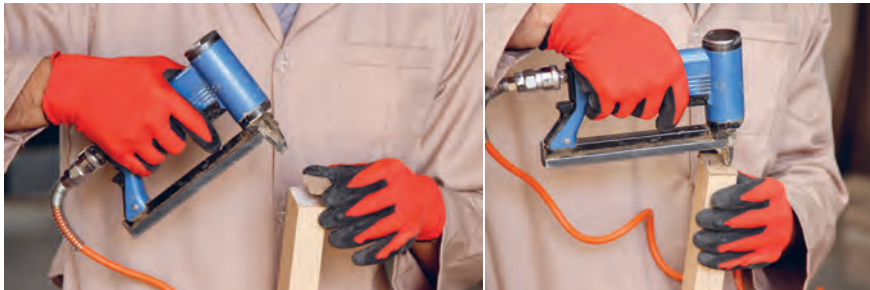
شکل ۱۱۱- مراحل نصب فیبر ۳ میلی متر با منگنه کوب
