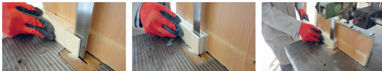
شکل ۹۰- عملیات برش زبانه با دستگاه اره نواری
