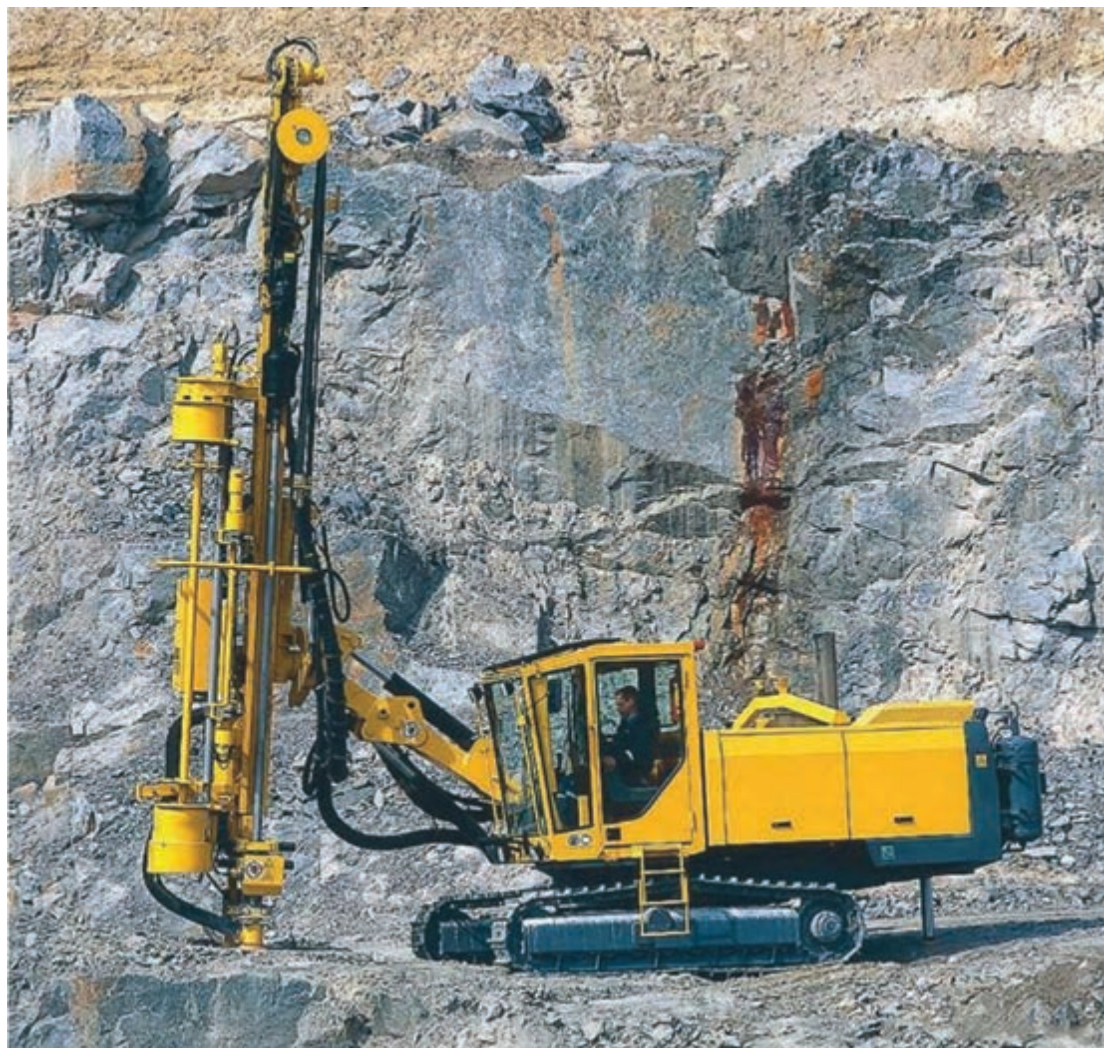
ماشین واگن دریل DTH در حال حفر چال‌های استخراجی بر روی پله معدن روباز
