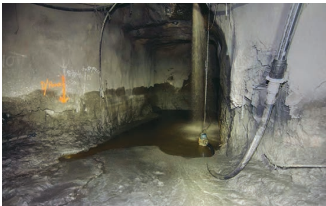
آب انبار در معدن زیرزمینی
