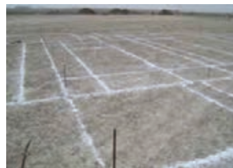
زمین گچ‌ریزی شده
