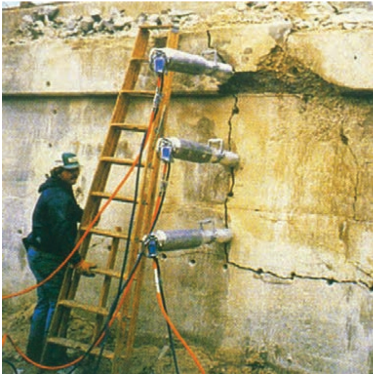
ابزار برش هیدرولیک سنگ
