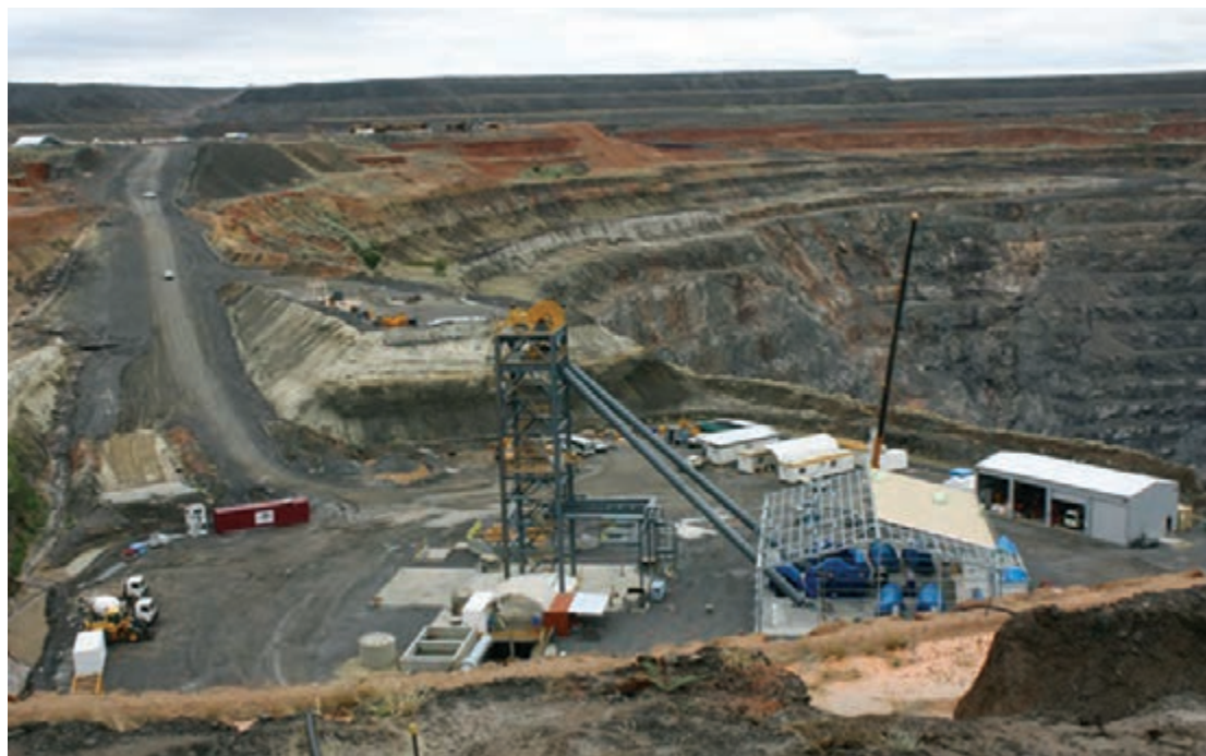
محوه سازی و تأسیسات احداث شده در اطراف یک معدن روباز
