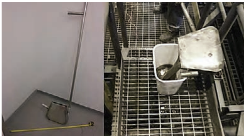
شکل ۳۵- تجهیزات نمونه‌گیری از کانال‌های بین سلول‌های فلوتاسیون (کاتر دستی)
