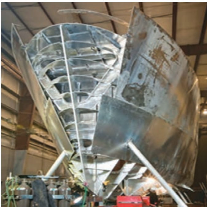
شکل ۲۳- سازهٔ سینهٔ یک شناور در حال ساخت
