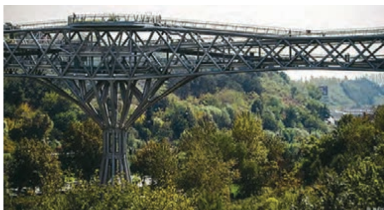
شکل ۱۰- نمونه‌ای از سازه‌های خرپا
