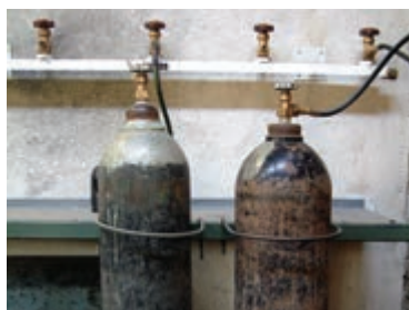
شکل ۲-۲۳- کپسول اکسیژن که به خط لوله گاز می‌رساند.
