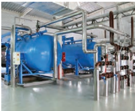
شکل ۱۲- سیستم زمستانه کردن روغن ها
