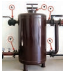
ب) تصویر واقعی شکل ۲۲- صافی شن
