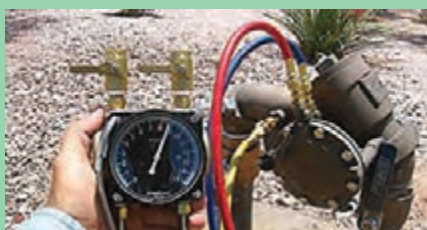
شکل ۱۷- تنظیم فشار شیر فشارشکن
