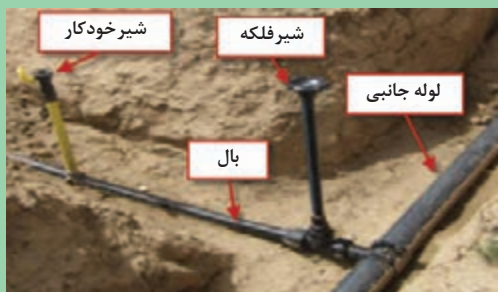
شکل ۱۱- محل شیر فلکه روی بال
