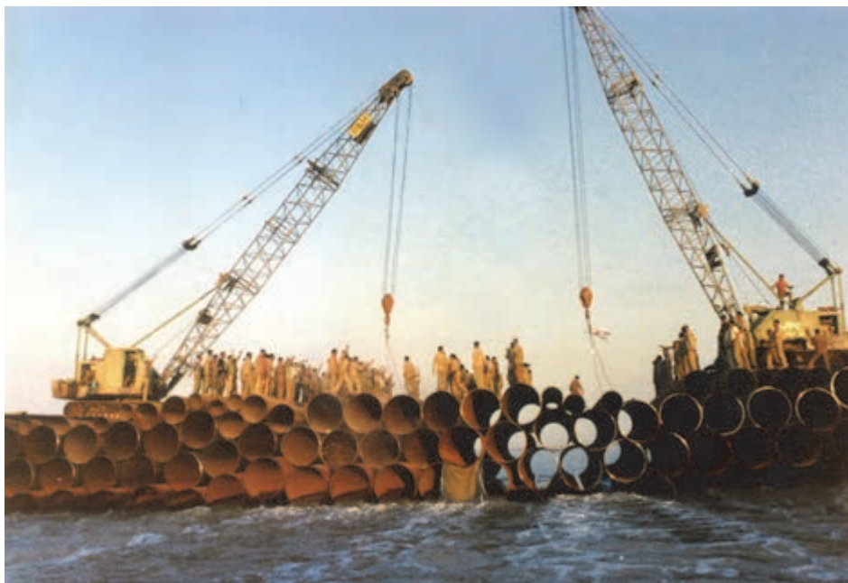
شکل ۱۱-۵- پل بعثت در حال ساخت
