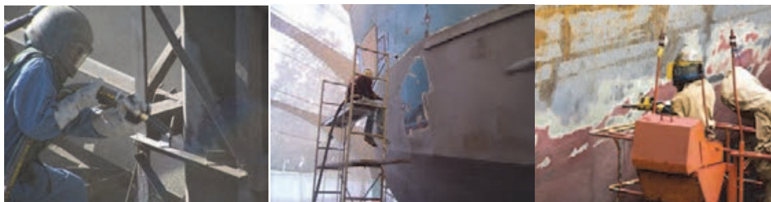
شکل ۱-۷ زنگ‌زدایی در اسکله خشک
