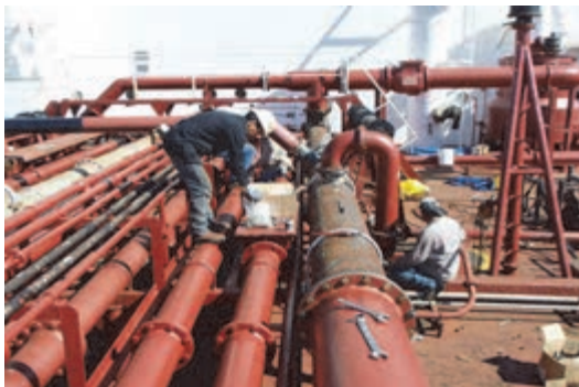
شکل ۷- در حال اجرای لوله‌کشی کشتی
