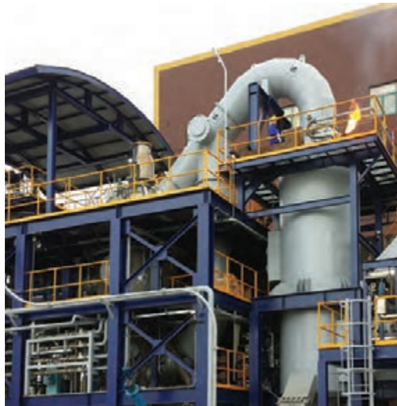
شکل ۲۵-۵- زباله‌سوز صنعتی
